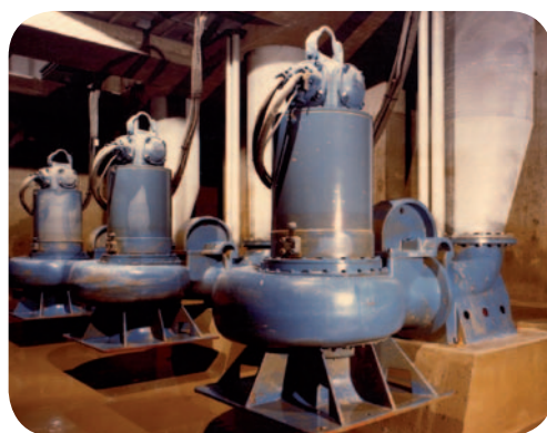
Pompes submersibles en fosse noyée
