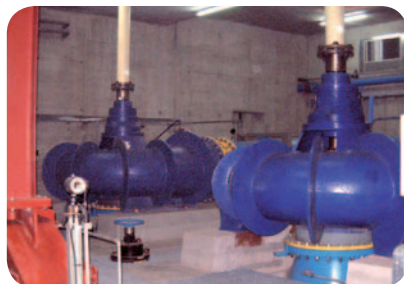
Pompe monocellulaire verticale à ligne d'arbre et cardan
