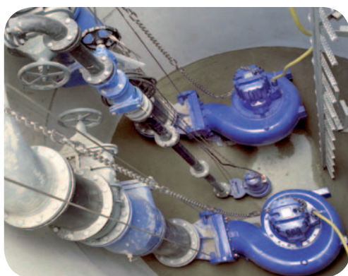
Pompes submersibles en fosse noyée
