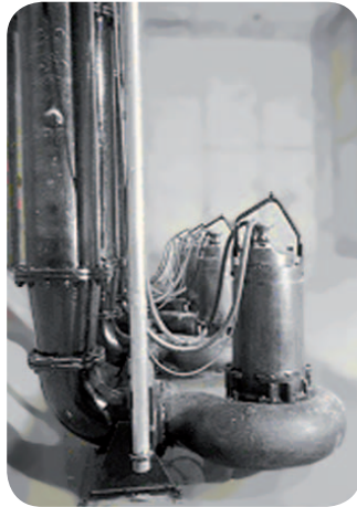
Pompes submersibles sur pied d'assise avec barre de guidage
