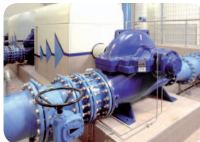
Pompe horizontale à plan de joint (capot d'insonorisation sur le moteur)
