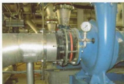
Exemple 2 (recommandé) : exemple d'un montage correct. L'effet de fond est compensé par des tirants. Photo en provenance du Guide Technique 2010 du SNECOREP (p. 34)
